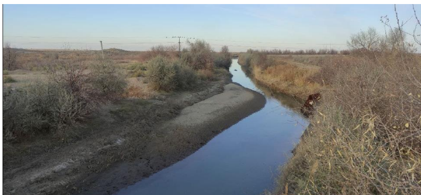
Рис. 9. Картина образования криволинейного русла и укрепления береговых откосов растительностью на участке ПК 110 – ПК 150
